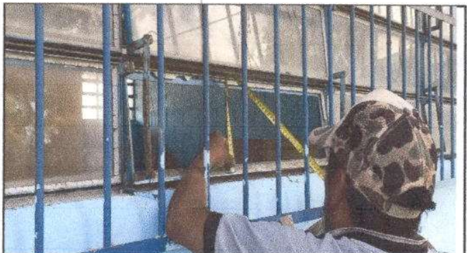
Foto 4: Sustitución de vidrios, un total de 28 unidades
